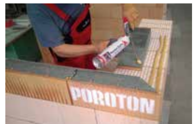
Zur Stabilisierung des Eckbereichs die Schnittfläche mit Poroton Dryfix-Kleber verkleben.
